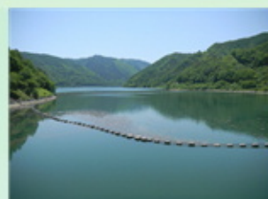
牧尾ダム 愛知用水の水源として完成した ロックフィルダム
